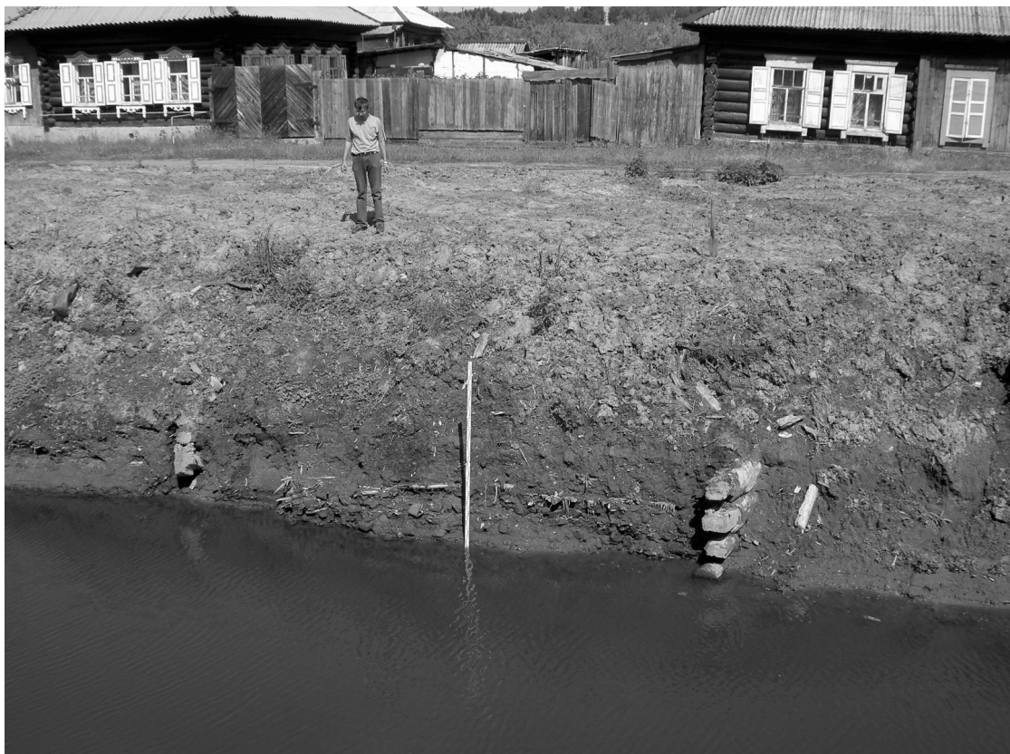
Рис. 3. Участок 4 с остатками мостовой конструкции. Вид с юго-запада
