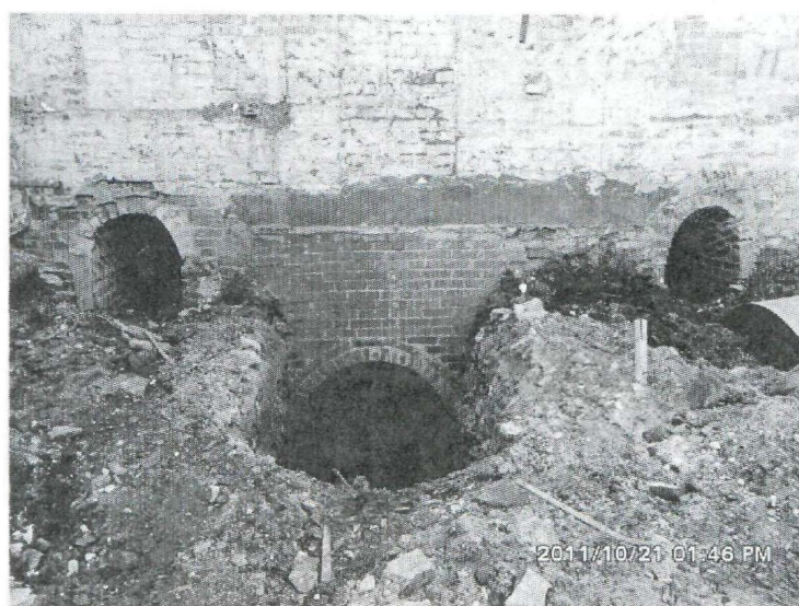
Рис. 5. Раскрытие арочных проемов в восточной стене. Снимок Т.А. Сучковой (сверху — обзорное фото, снизу — детали)
